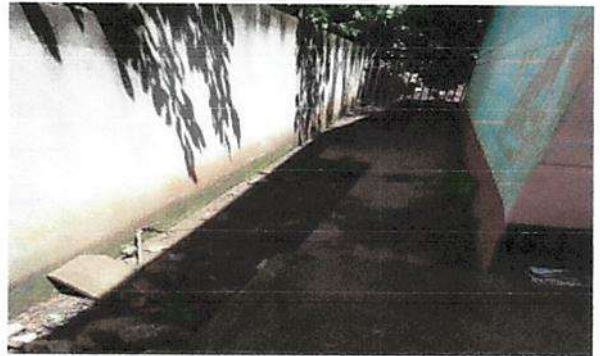
Foto 4: Reparacion de Losa de Patio ✓
