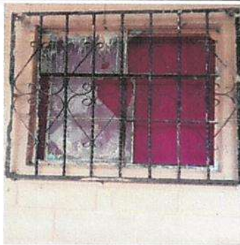
Foto 5: Suministro e instalacion de ventanas de pvc ✓
