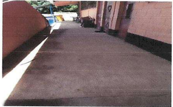
Foto 2: Colocacion de piso de granito ✓
