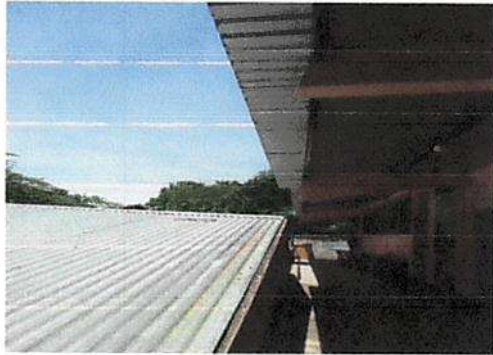
Foto 3: Colocacion de canales y bajadas de agua ✓
